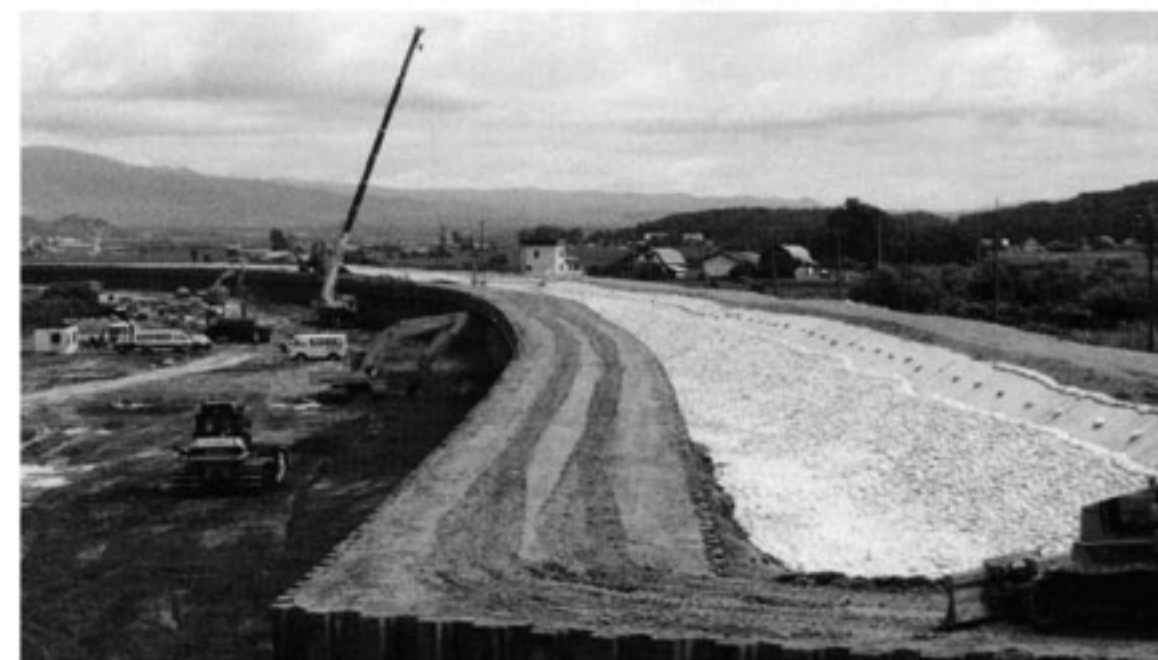
▲後志利別川真栄橋左岸上流地先緊急復旧工事
